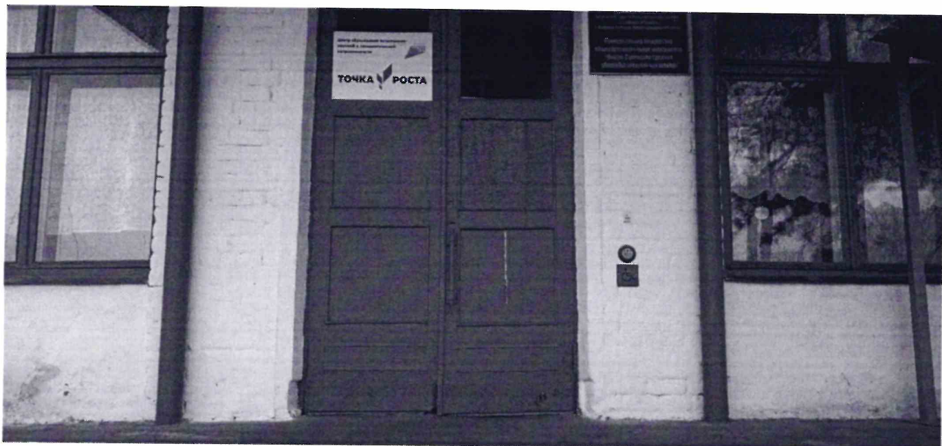
Фото входа (входов) в здание
